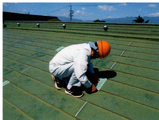
屋根鋼板のコーキング補修中
