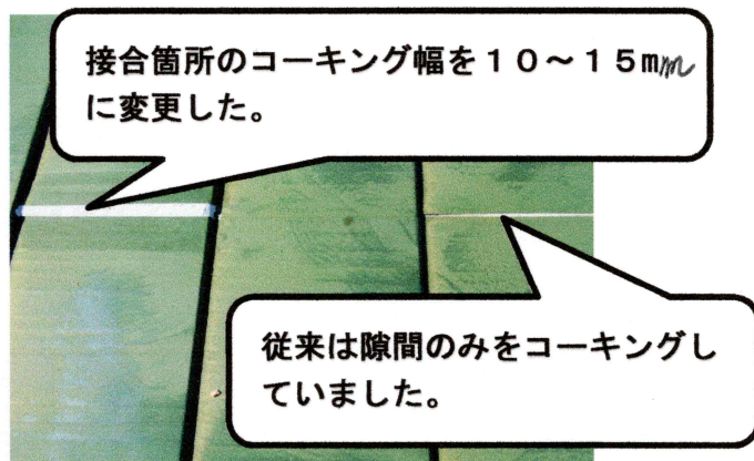
屋根鋼板のコーキング補修中
